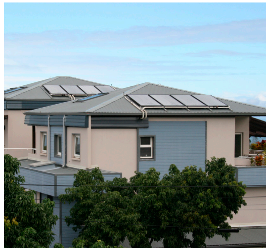
Instalación individual separada.
